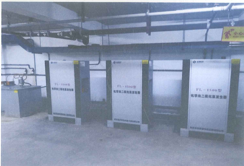
院区污水处理站
